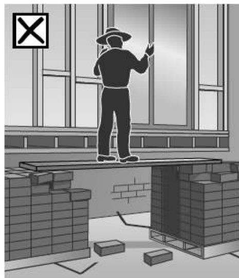
18 pav. Draudžiama naudoti atsiktines paaukštėjimo priemones
